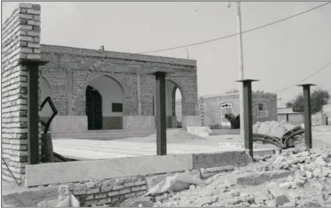
مسجد صاحب الزمان (عج) در حال احداث
